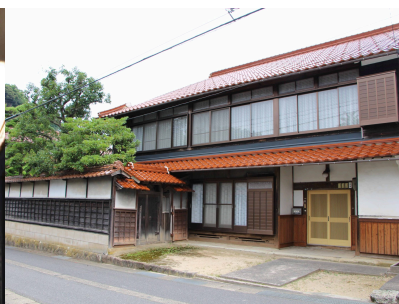
道盛家住宅 (兵庫県新温泉町)
